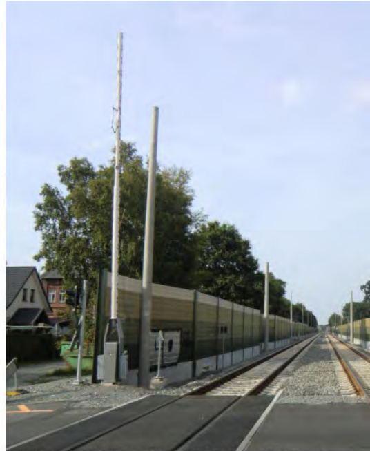
Bahnübergang Jaderberg/ Raiffeisenstraße mit Gleisausbau und Elektrifizierungsmasten
