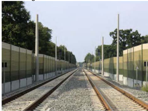
Bahnübergang Jaderberg/ Raiffeisenstraße mit Ausbau und Elektrifizierungsmasten
