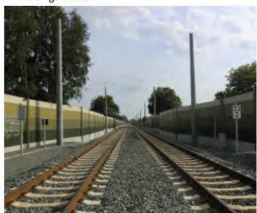
Bahnübergang Jaderberg/ Raiffeisenstraße mit Ausbau und Elektrifizierungsmasten
