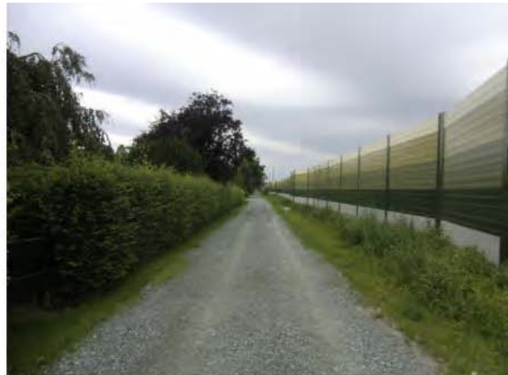
Ausgebaute Bahnstrasse in der Ortschaft Jaderberg, Blickrichtung: Norden
