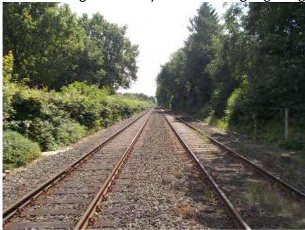
Bahnübergang Bürgerbuschweg, Blickrichtung: Süden
