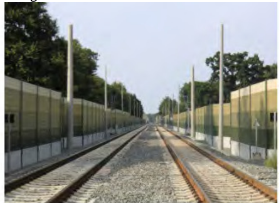
Bahnübergang Jaderberg/ Raiffeisenstraße mit Ausbau und Elektrifizierungsmasten
