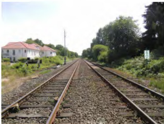
Bahnübergang Karuschenweg, Blickrichtung: Süden
