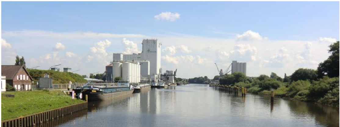
Abb. 4.1: Gewerbeflächen östlich der Hunteklappbrücke (Agravis-Silos)
