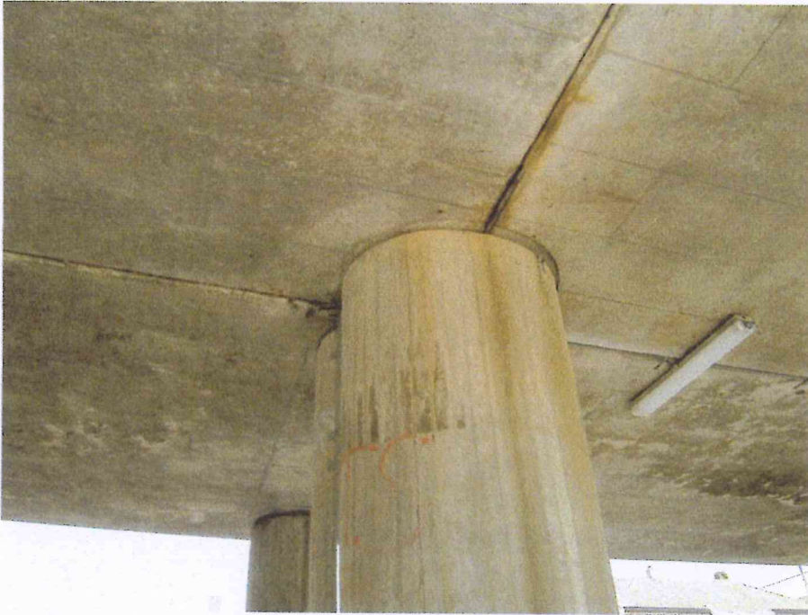
Querfuge mit Korrosions- und Durchfeuchtungsspuren
