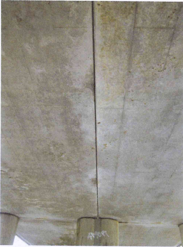
Verfärbungen und Aussinterungen an der Längsfuge
