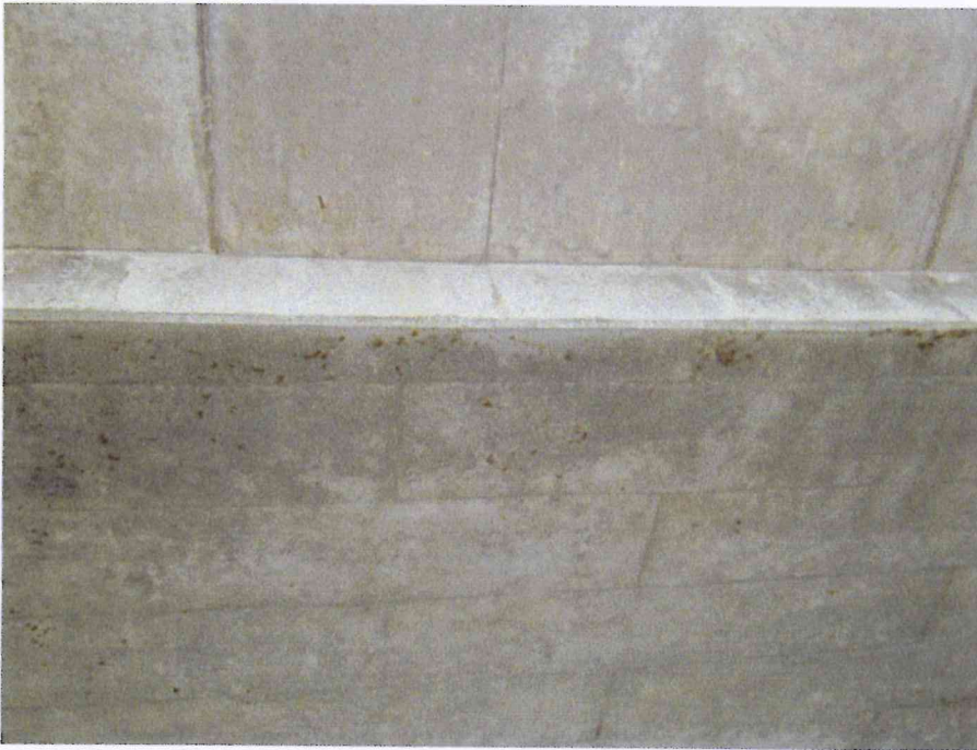
Korrodierte Rödeldrahtreste
