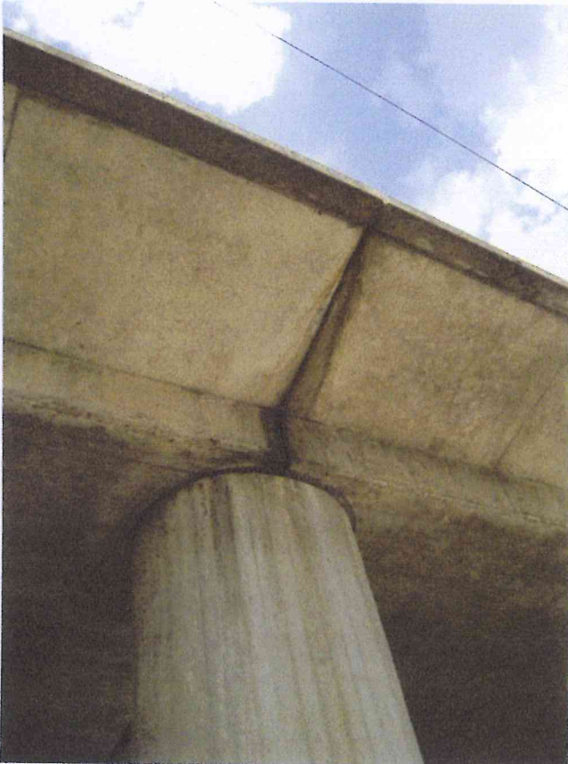
Querfuge mit Korrosions- und Durchfeuchtungsspuren
