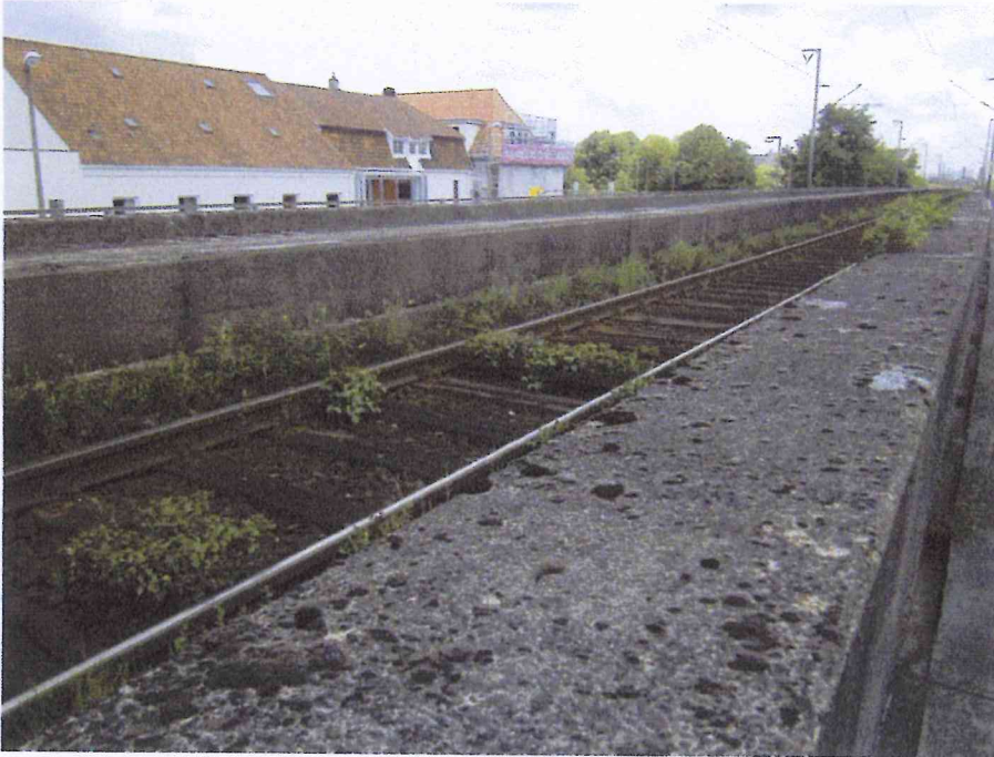
Brückenseite mit Trogseitenwand
