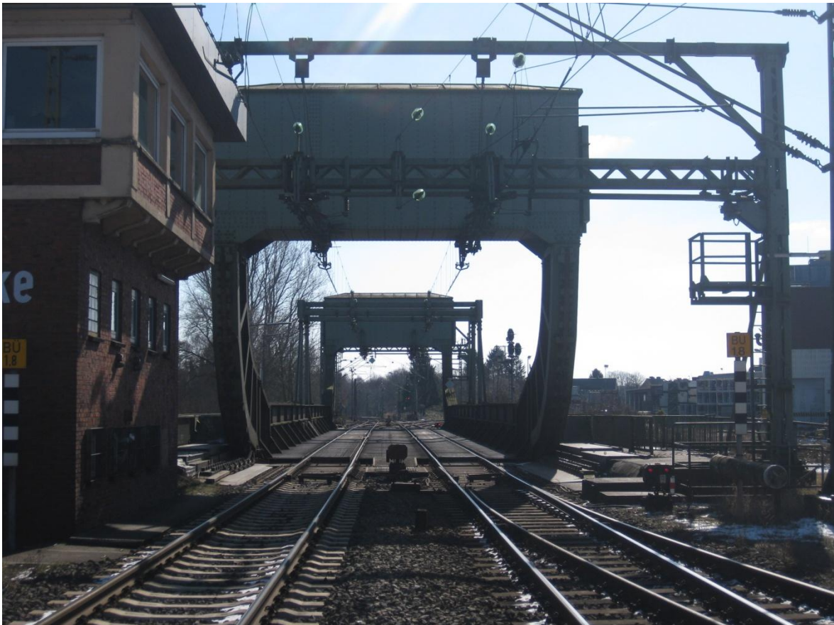
Abbildung 4: Querung der Hunte – KBS 390, Blick von Norden, © PB, VWI GmbH
