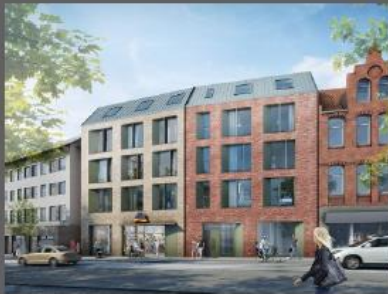
Neubau von zwei Wohn- und Geschäftshäusern mit Tiefgarage in Hannover Kirchrode Bauherr: Gundlach GmbH & Co. KG Beauftragte Leistung: LPH 1-5, Oberbauleitung
