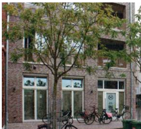
Neubau Ecke Burgstraße 24
