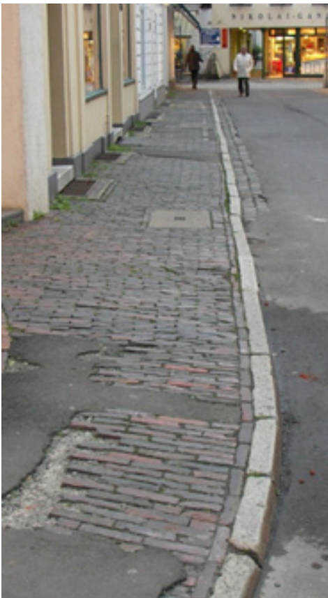
Die Burgstraße vor Beginn der Sanierung
