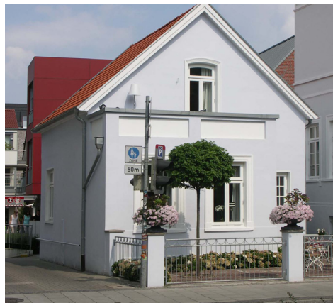
Modernisierung Theaterwall 24a
