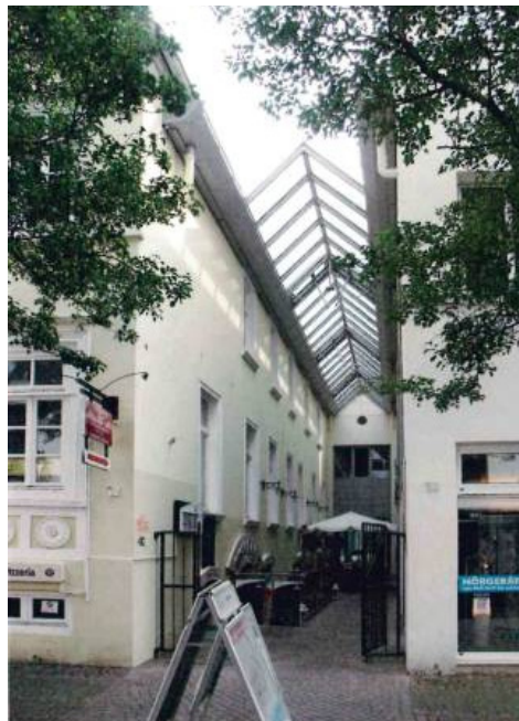
Passage Boykengang, Eingang Kurwickstraße
