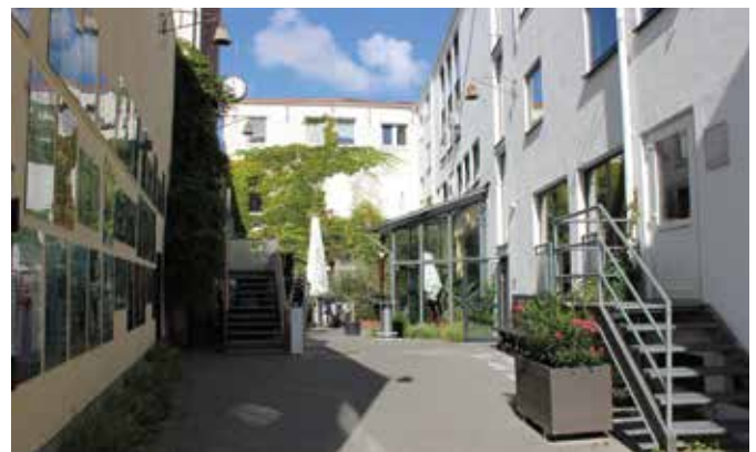
Innenhof der Kulturetage nach der Sanierung
