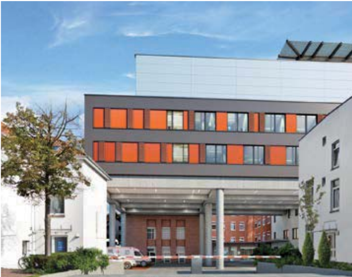
Evangelisches Krankenhaus Oldenburg, Umbau Sicherheits- und Gesundheitsschutzkoordination Health and safety coordination
