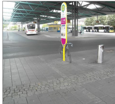
Abbildung 22: Fehlende Führung zu Steig H (Quelle: Eigenes Foto)
