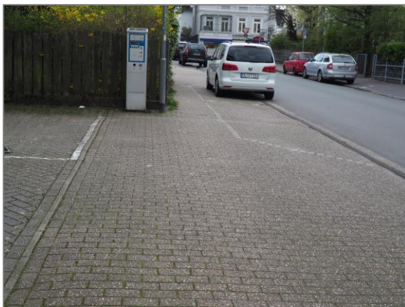
Abbildung 1: Engstelle im Gehweg durch Längsparken (Quelle: Eigenes Foto)
