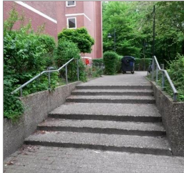
Abbildung 26: Beispiel für kontrastarme Treppenanlage (Quelle: Eigenes Foto)
