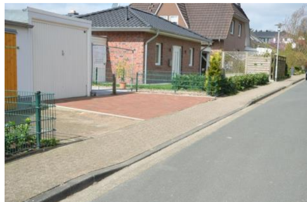
Görlitzer Straße, nördlicher Teil
