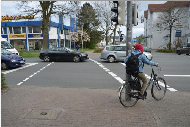
Abbildung 6: 0 cm Absenkungen ohne taktile Sicherungen (Quelle: Eigenes Foto)
