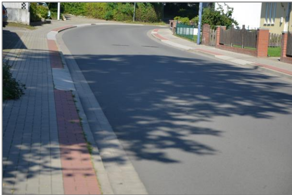
Abbildung 4: Schrägbordstein als Lösung in gesamter Straße (Quelle: Eigenes Foto)
