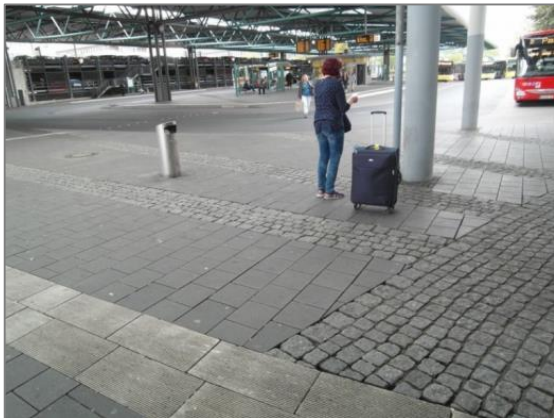
Abbildung 21: Leitsystem und Kleinpflasterstreifen am ZOB (Quelle: Eigenes Foto)
