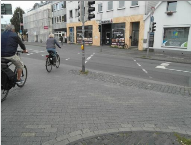
Abbildung 14: Beispiel für sehr schmale Aufstellfläche zwischen Fahrbahn und Radweg (Quelle: Eigenes Foto)
