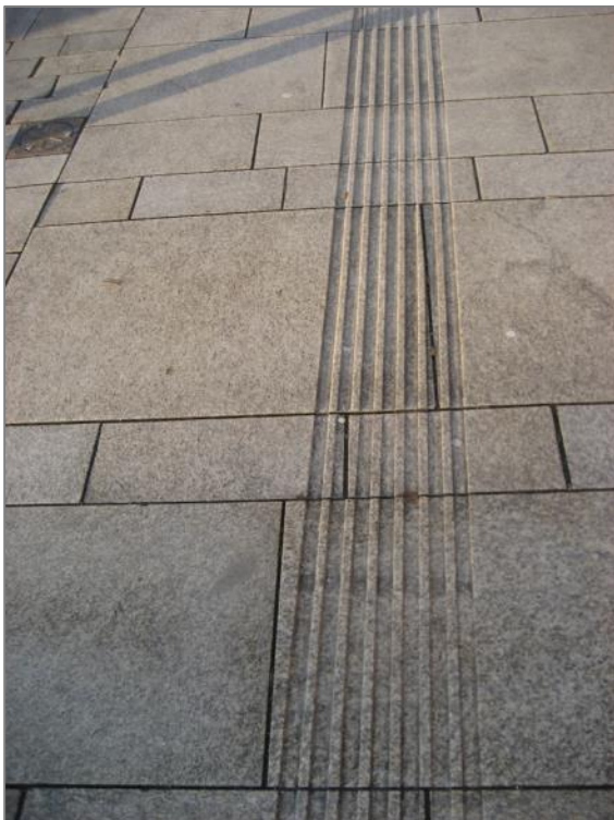
Abbildung 25: Beispiel für eingefrästen Leitstreifen (Stadt Verden) (Quelle: Eigenes Foto)
