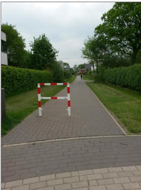
Abbildung 27: Unterlaufbare Umlaufschranke (Quelle: Eigenes Foto)
