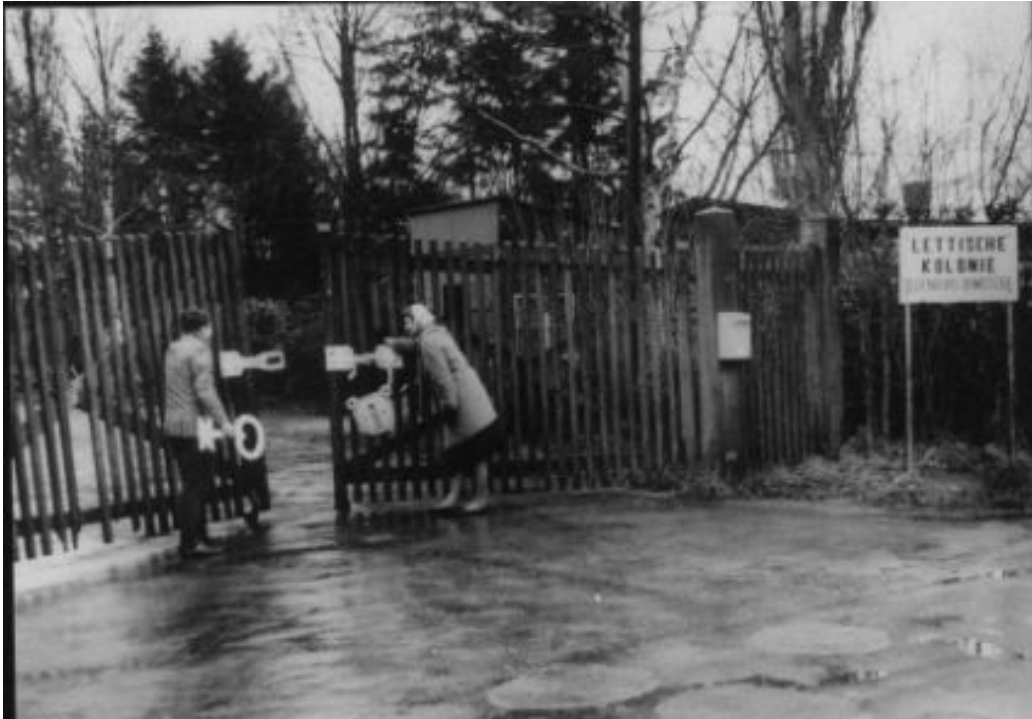
Eingangstor zur Lettischen Kolonie an der Rennplatzstraße
